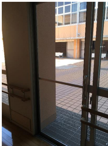
換気のために網戸の設置
