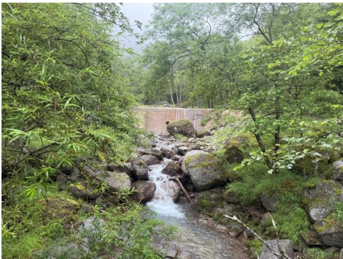
通過地点①堰堤広場
