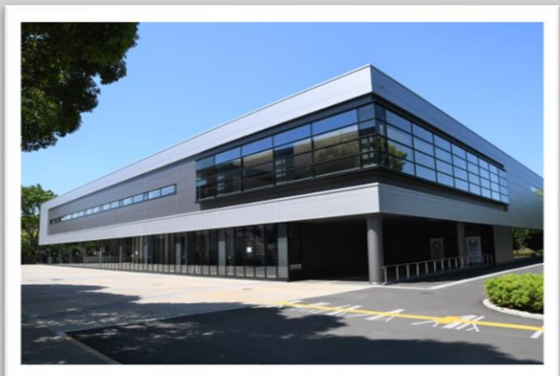
令和2年4月オープンの体育指導センターの執務室があるスポーツセンター
