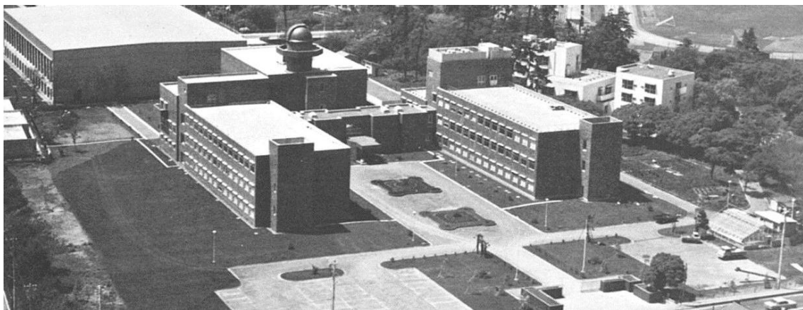
図5 第3期工事及び温室完成後の教育センター
