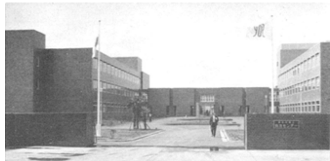
図4 第2期工事で完成した研修棟（左）
