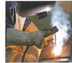
溶接実習の様子
