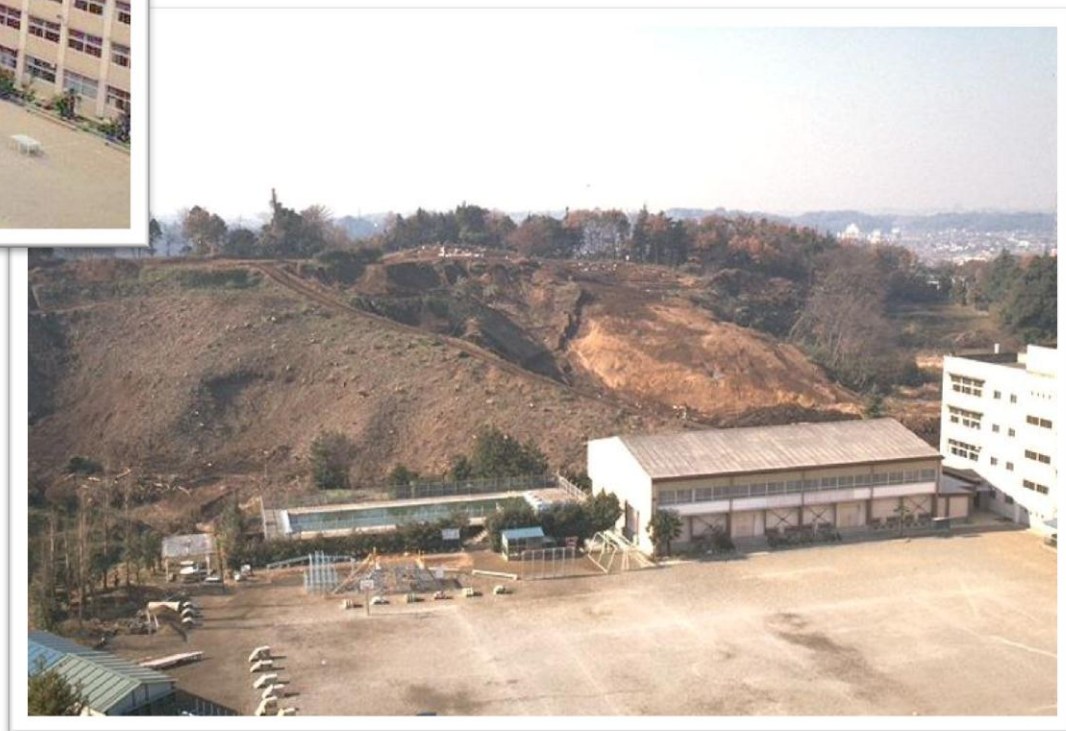
樹木を伐採した後(手前の校舎は篠原西小学校)
