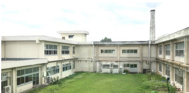
2021 1棟耐震補強工事竣工（向かって左）
