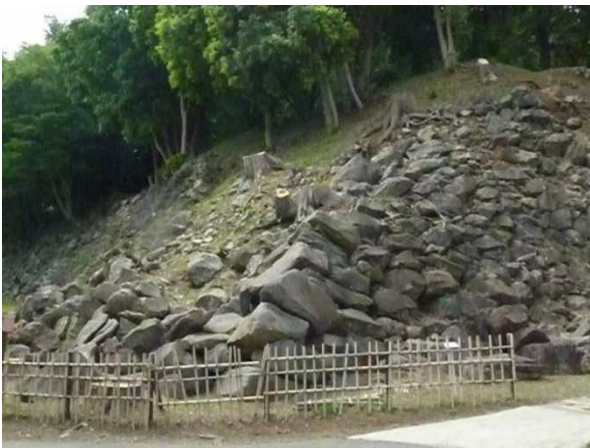
図1 野面積み 見た通り、形が不揃いな石が積み上げられている。
