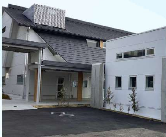
2026年建設科材料試験室竣工
